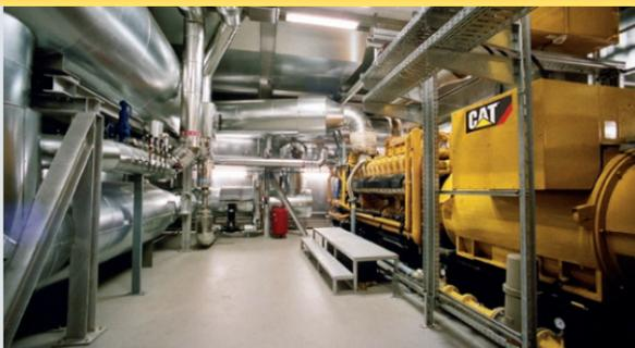
Die Versorgung mit Strom und Wärme mittels Blockheizkraftwerken ist eine hochinteressante, wirtschaftliche und ökologisch sinnvolle Alternative zum Bezug von Netzstrom. Zeppelin liefert BHKWs als komplette Anlagen mit Caterpillar Gasmotoren. Auf Wunsch hilft Zeppelin seinen Kunden in jeder Projektphase, von der Konzeption, der Ausführungsplanung, der Inbetriebnahme bis hin zur Wartung und Instandhaltung ihrer Anlagen.
