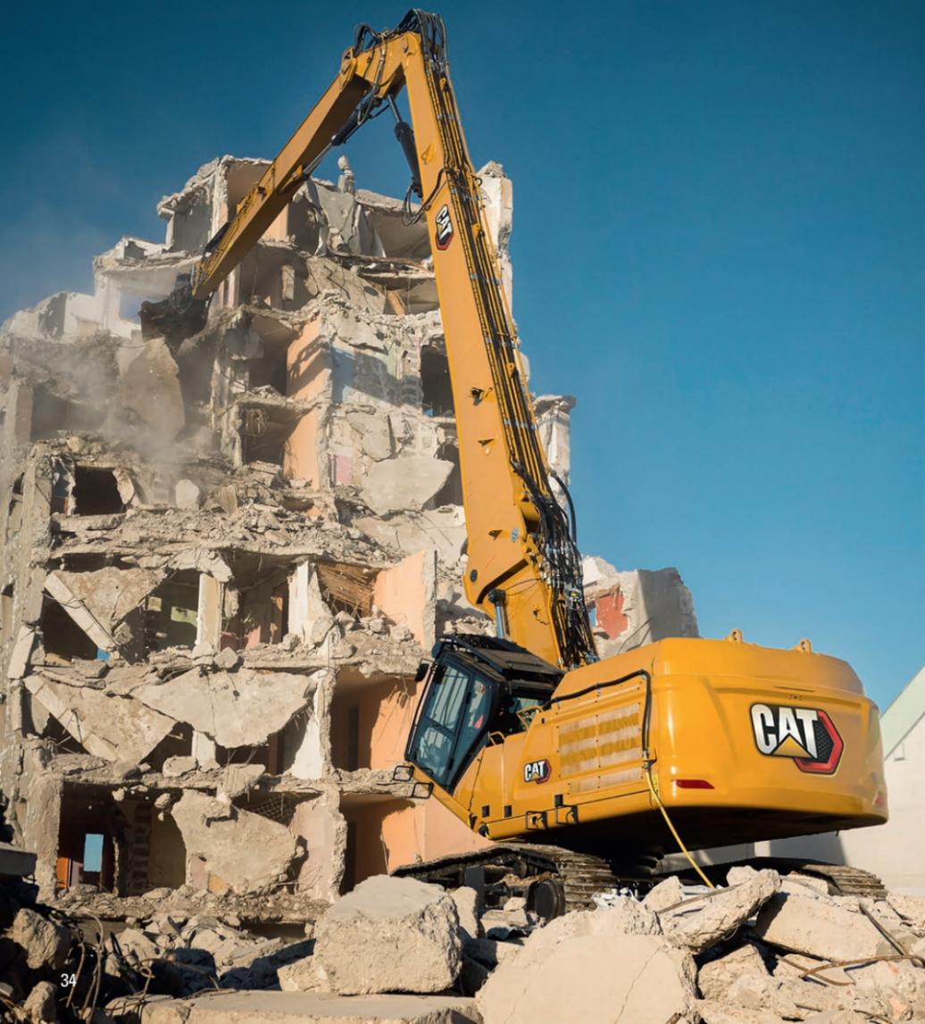
Auch alle Cat Abbruchbagger kommen jetzt auf Basis der Maschinen der neuen Generation mit elektrohydraulischer Vorsteuerung. Der 340 SB ist eine Abbruchversion des Cat 340 mit geradem Ausleger, speziell auf typische und schwere Anbaugeräte im Rückbau ausgelegt.
