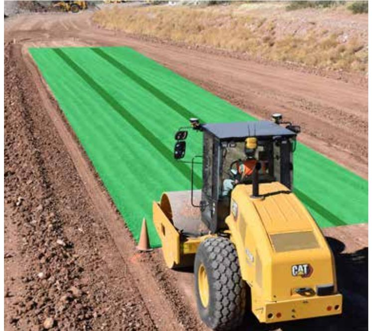
COMMAND SORGT FÜR EINE GLEICHBLEIBENDE ÜBERLAPPUNG UND DURCHLAUFZAHL. SO WIRD EINE EINHEITLICHERE VERDICHUNG MÖGLICH.
